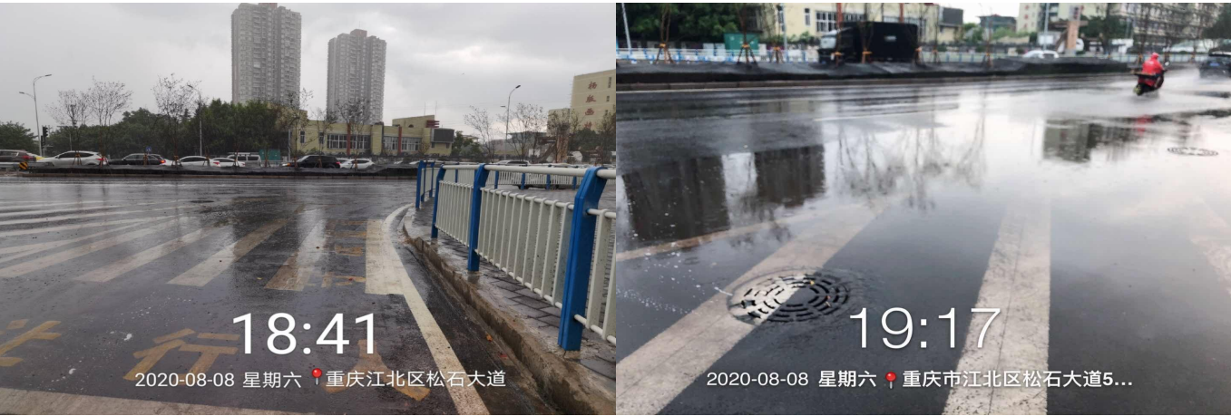
图 5-5 内涝点—高石坎路口
